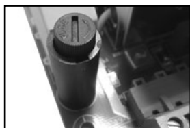
Figure 6 : Remplacement de fusible
